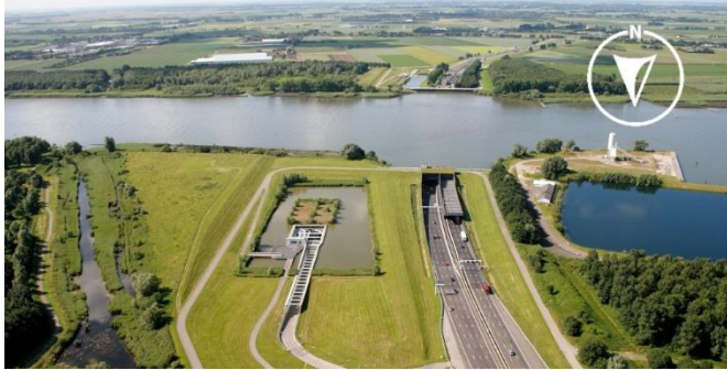
Figure 7 Birds-eye view of the Eerste Heinenoordtunnel (right) and the Tweede Heinenoordtunnel (left). Image from https://beeldbank.rws.nl , Rijkswaterstaat.
