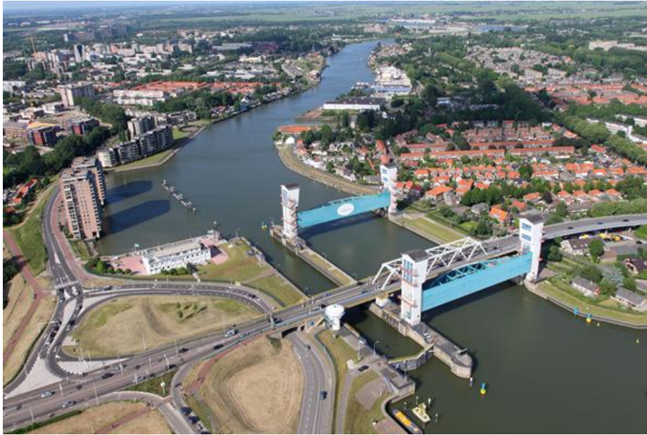
Fig. 5. The Algra complex consisting of a lock, a bascule bridge, and two storm surge barriers [ https://beeldbank.rws.nl , Rijkswaterstaat / Joop van Houdt].
