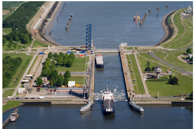
Fig. 1: The lock at Terneuzen, The Netherlands. Image from https://beeldbank.rws.nl , Rijkswaterstaat.
